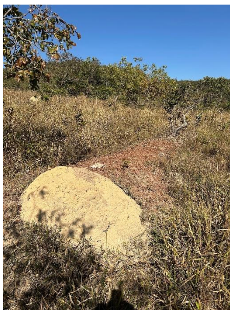
Figura 14 – Barraginha formada por solo acumulado, servindo de barreira contra erosão no pasto.
