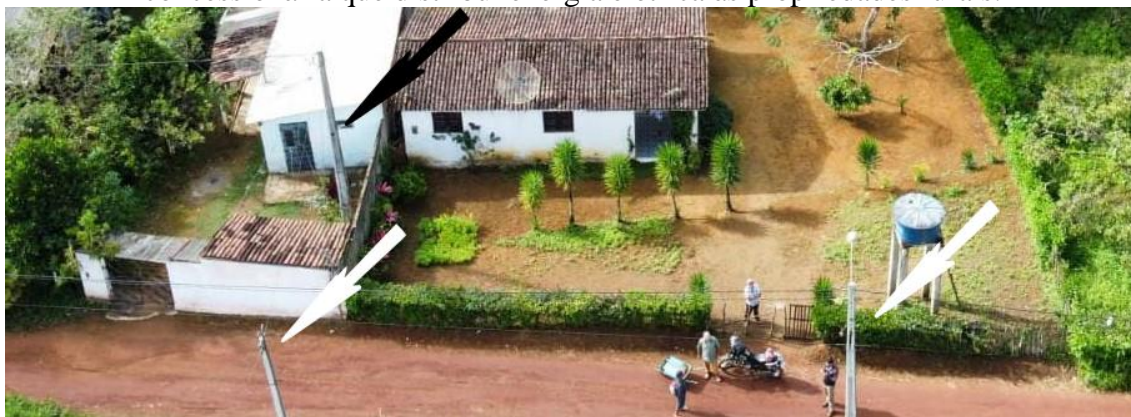
Figura 3 – Detalhe da foto da Figura 2B, mostrando os postes (indicadas pelas setas) da concessionária que distribui energia elétrica às propriedades rurais.
