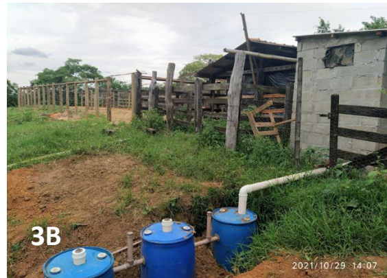
Figuras 3A e 3B - Sistema de biodigestores anaeróbicos para tratamento do esgoto doméstico.
