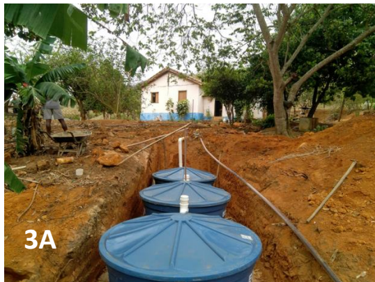
Figuras 3A e 3B - Sistema de biodigestores anaeróbicos para tratamento do esgoto doméstico.
