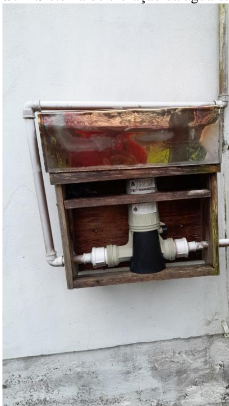
Figura 9 - Sistema de cloração da água captada.
