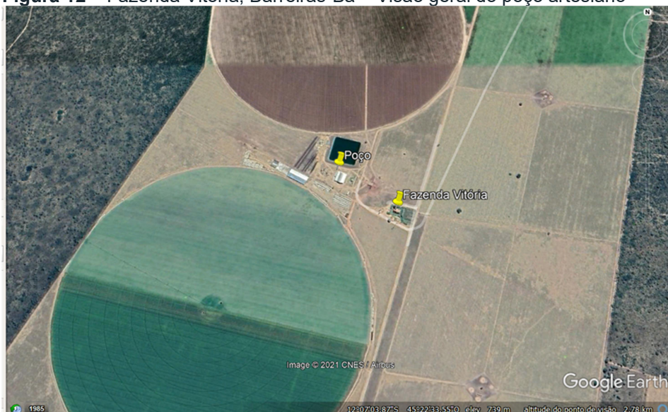
Figura 12 – Fazenda Vitória, Barreiras-Ba – Visão geral do poço artesiano
