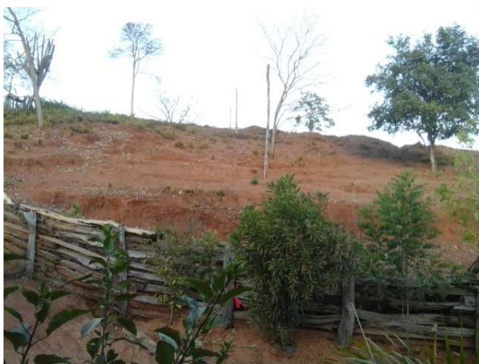
Figura 10: Barreiras construídas para conter erosão.
